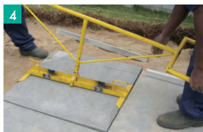
4 Colocação das placas de concreto com saca-placas.
