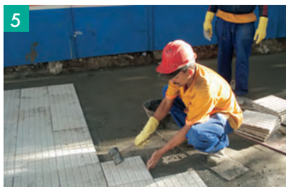
5 Assentamento das placas.
