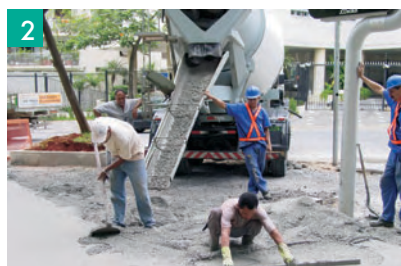
2 Lançamento, espalhamento e nivelamento (sarrafeamento) do concreto.
