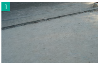
1 Nivelamento e compactação do subleito e execução da base de concreto magro.
