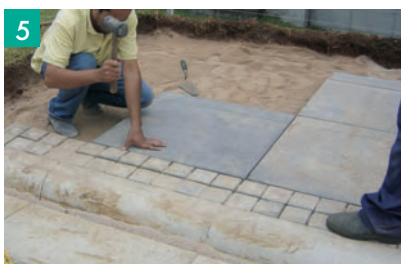
5 Execução de cortes, ajustes e alinhamento.
