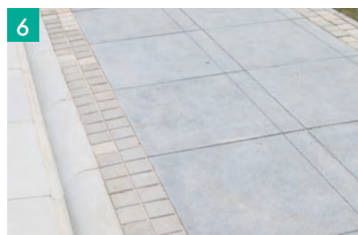
6 Limpeza e liberação ao tráfego.
