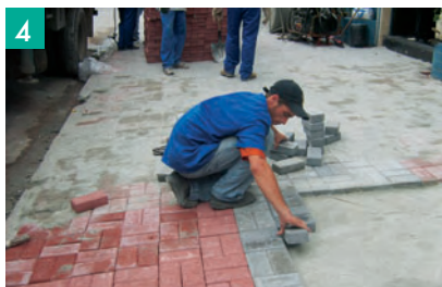
4 Colocação das peças de concreto, alinhamento, cortes e ajustes.
