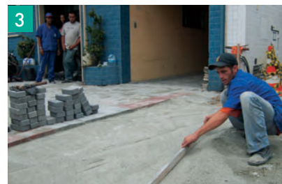
3 Espalhamento e nivelamento de areia de assentamento.
