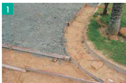
1 Nivelamento e compactação do subleito, colocação de brita, instalação das formas e telas de aço.
