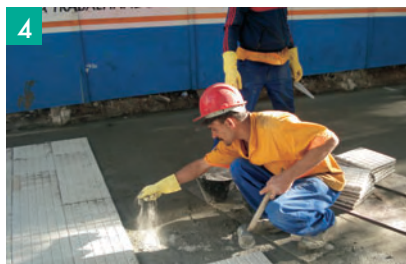
4 Aplicação de cimento pulverizado e água (etapa não necessária para argamassa colante).
