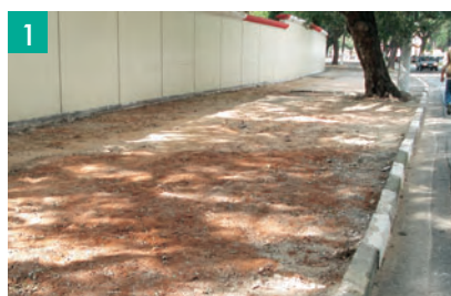
1 Nivelamento e compactação do subleito (terreno).
