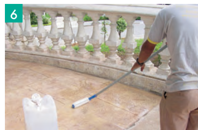
6 Execução de juntas de controle, cura com água, aplicação de resina, lavagem e liberação ao tráfego.
