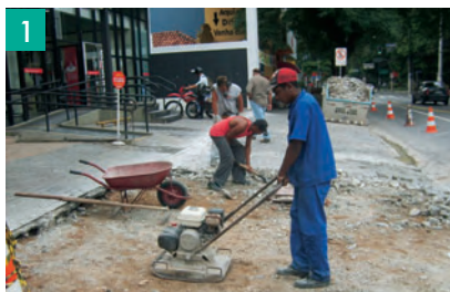
1 Nivelamento e compactação do subleito (terreno).
