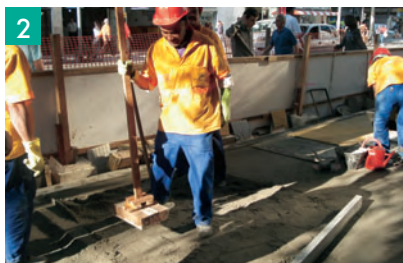
2 Aplicação e adensamento da argamassa de assentamento tradicional (ou argamassa colante).
